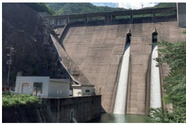
【郡上市】 阿多岐水力発電所
